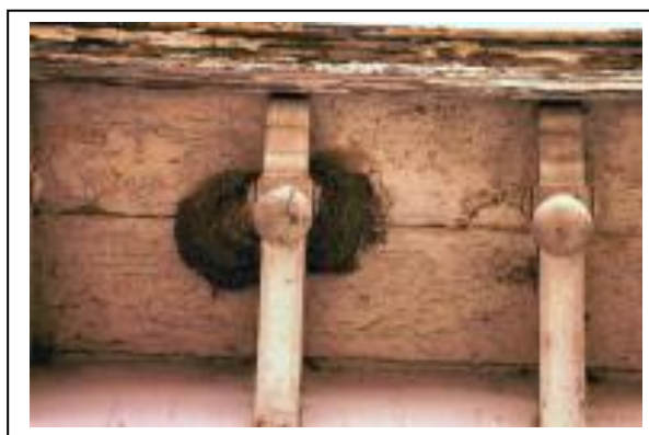
Fig. 19: Onderzijde van de gevel in Bossuit
