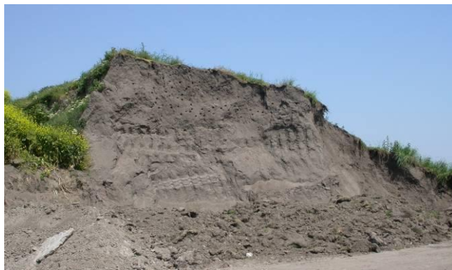
Oeverwaluwwand op de depot van de firma Seru - Welvaartstraat- Veurne (foto 2004)
