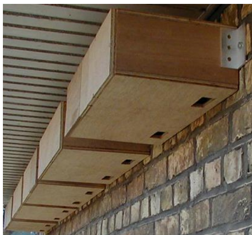
Vijf nestkasten met telkens twee nestruiden : 10 nieuwe nestgelegenheden voor de gierzwaluwen in het Sint-Bernarduscollege te Nieuwpoort
